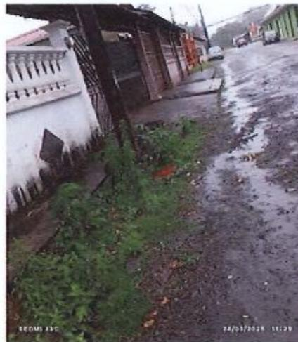
Fig. 5 No hay acera y el agua corre por donde puede. Los pozos cerrados mal estado no cumplen con las especificaciones de la Municipalidad.
