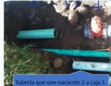
Tubería que une naciente 2 a caja 1. Tubería está colocada y enterrada. Se han colocado válvulas de interconexión. Ejecutado
