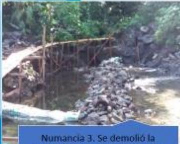
Numancia 3. Se demolió la estructura anterior, se excavó donde se colocará el nuevo muro. Ejecutado
