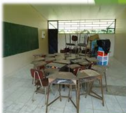
Falta de mobiliario
